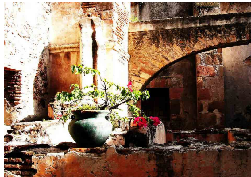
EL Convento de la Santa Cruz se construyó en 1683 para atender a los misioneros que llegaban a evangelizar la zona de Santiago de Querétaro.
